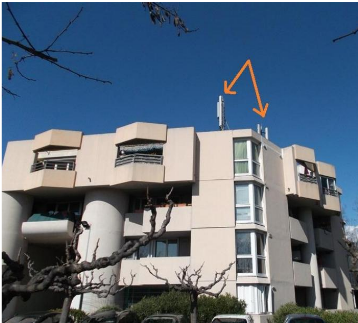
vue 2 : Vue de près. Pas de modification visuelle
