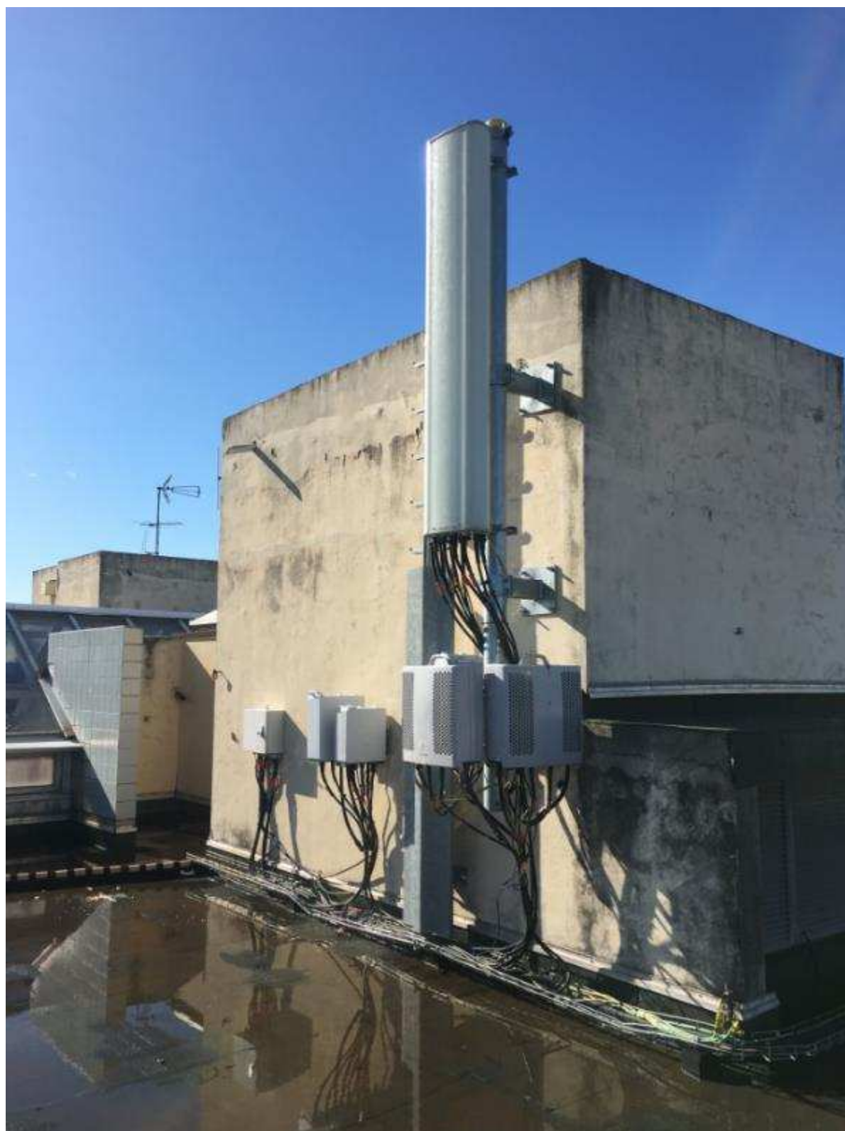
Vue 2 : Avant travaux
