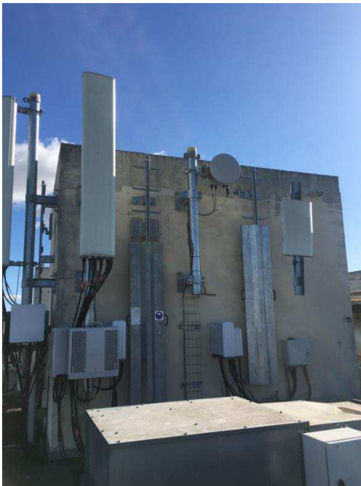
Vue 3 : Après travaux
