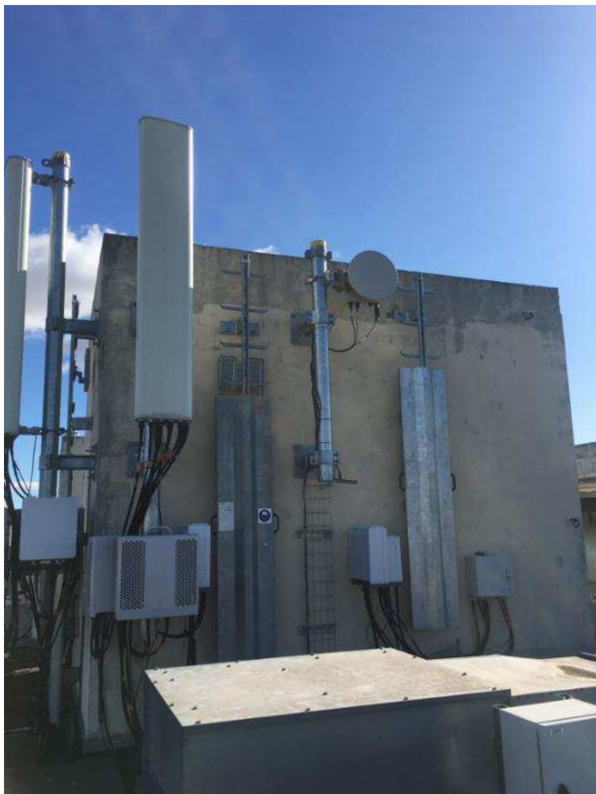
Vue 3 : Avant travaux
