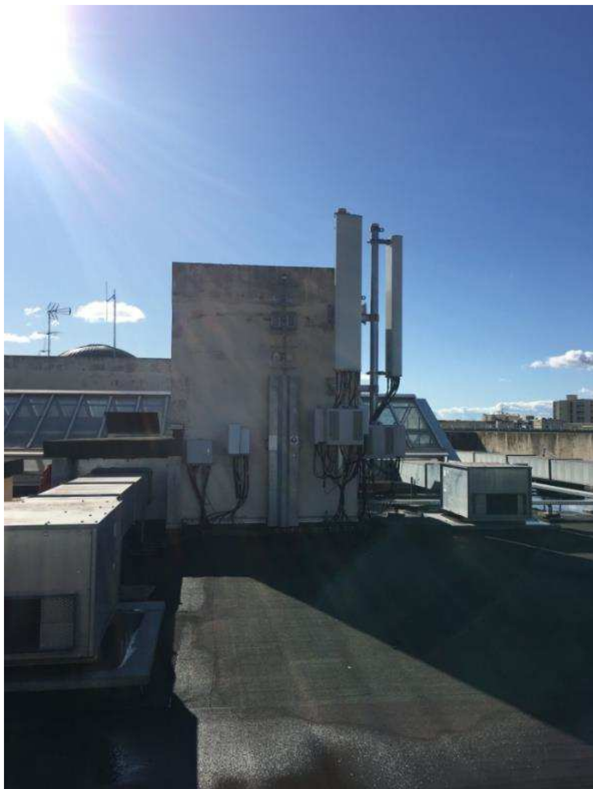
Vue 1 : Avant travaux
