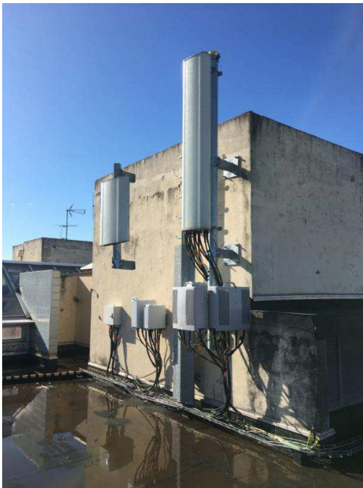
Vue 2 : Après travaux
