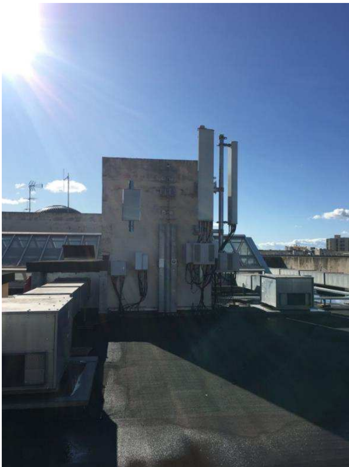
Vue 1 : Après travaux
