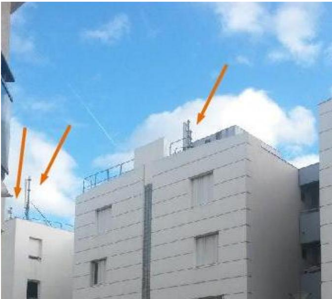
vue 2 : Photo du site existant depuis la rue Pouget; Pas de modification de l'aspect extérieur
